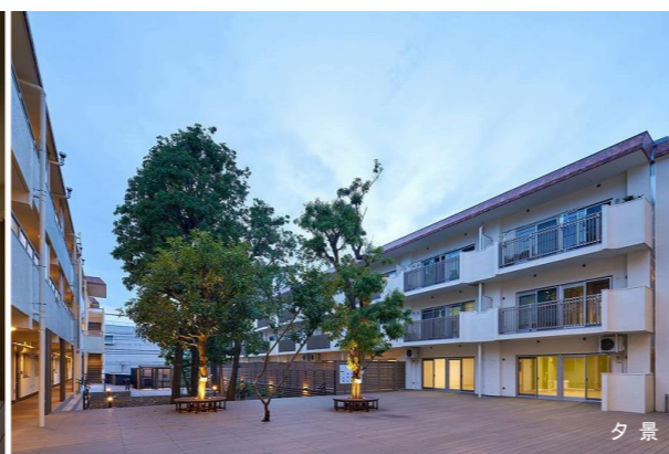
▲1階手摺壁を撤去し、中庭デッキ広場に
