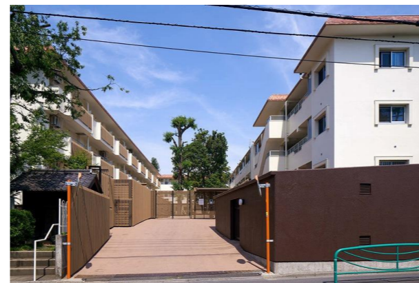
▲サブエントランスもセキュリティ化
