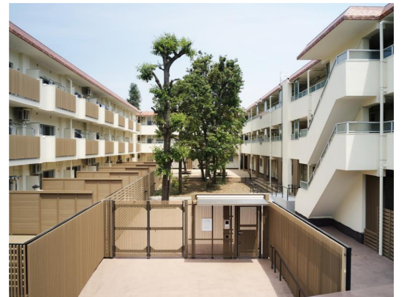
▲(上)敷地全体 / (下)西側サブエントランスより
